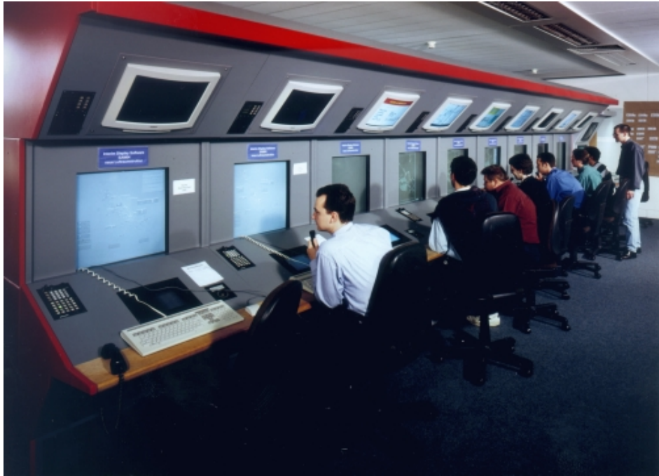
Abbildung 2.7: Fluglotsenarbeitsplätze für die Simulation in Training und Entwicklung bei der DFS.
